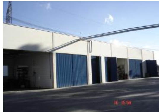
Figura - 7 Área de Jateamento/ Pintura / Solda
