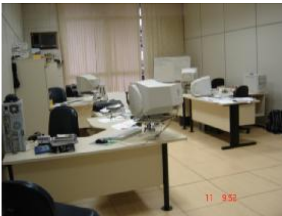
Figura – 10 Sala de Manutenção Telecomunicação
